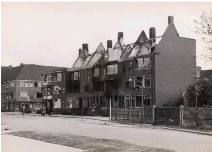
Verwoeste huizen Paterswoldseweg, hoek Lorentzstraat
